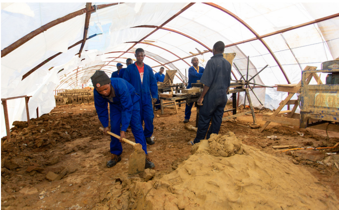
Préparation manuelle finale avant l'extrusion
