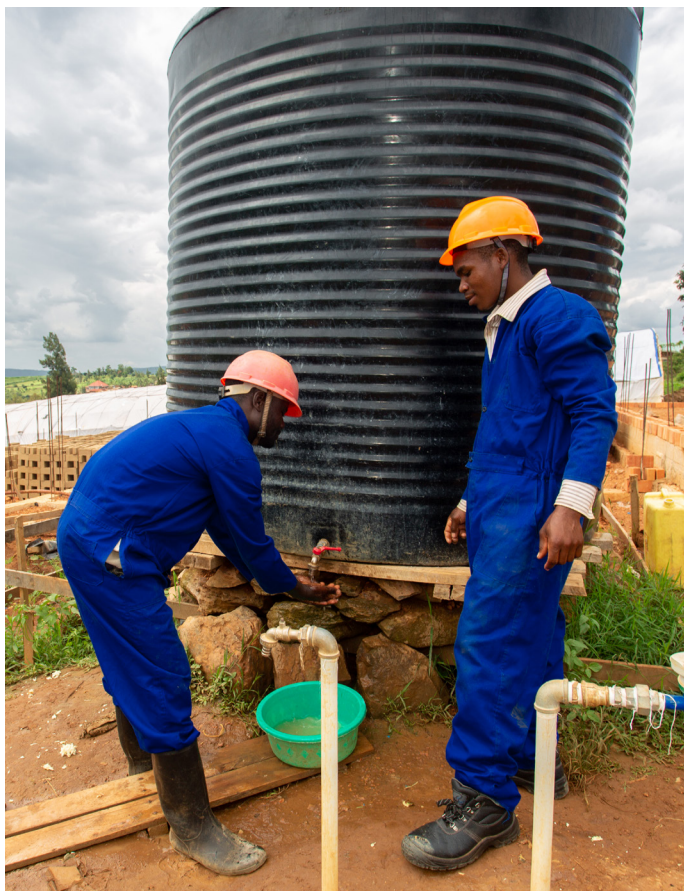
Les travailleurs en équipements de protection individuelle et d'eau propre sur le site
