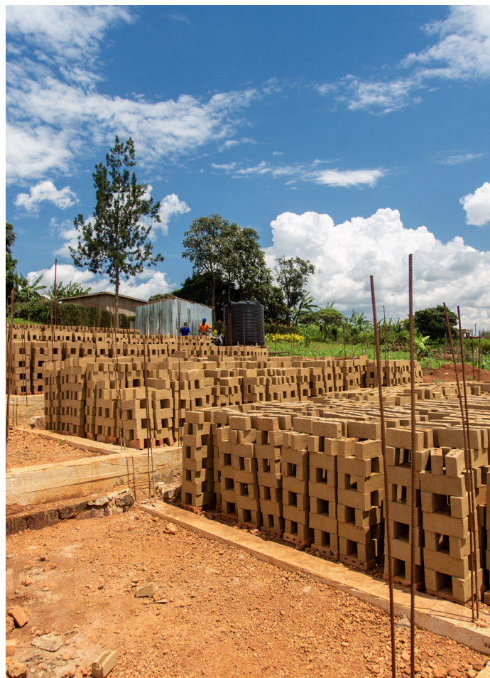
Empilage rectangulaire pendant le séchage secondaire
