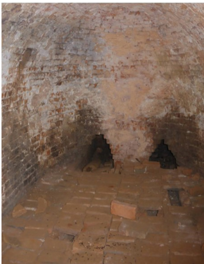
Le four avant sa maintenance
