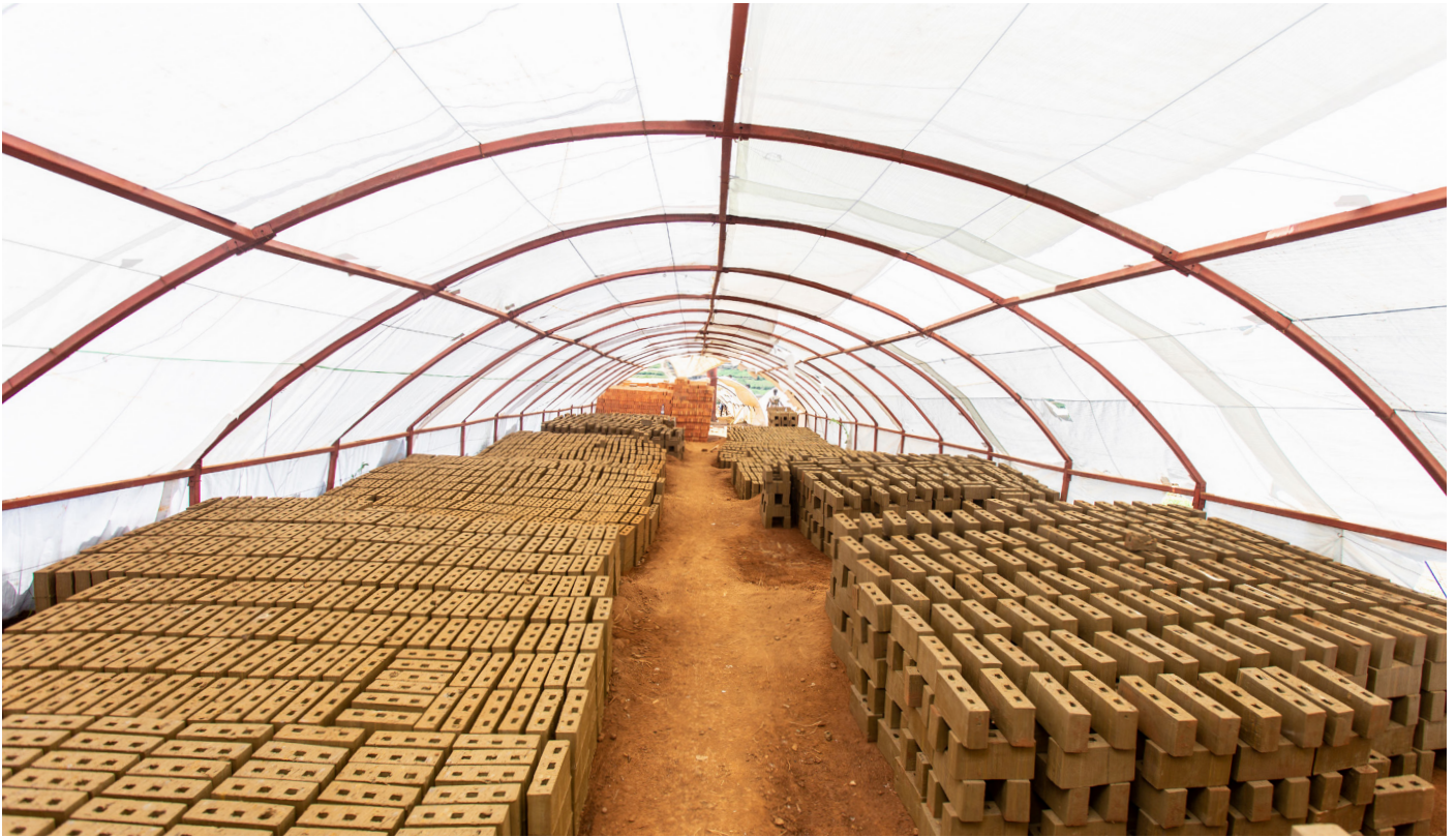
Séchage du produit vert (première étape à gauche et deuxième étape à droite)
