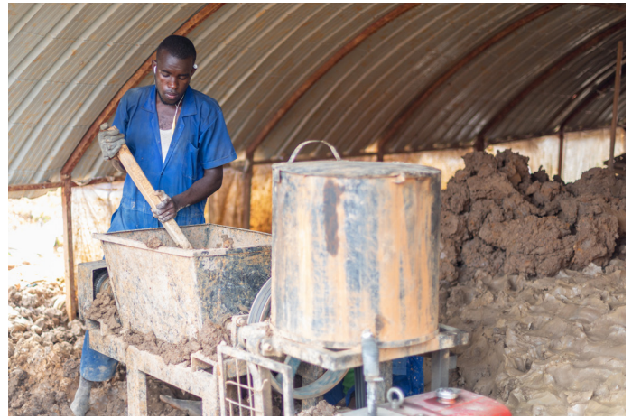
Broyage d'argile à l'aide d'un broyeur diesel motorisé de 30 CV
