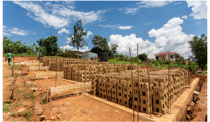
Briques prêtes pour la cuisson avec une teneur en humidité < 2\%
