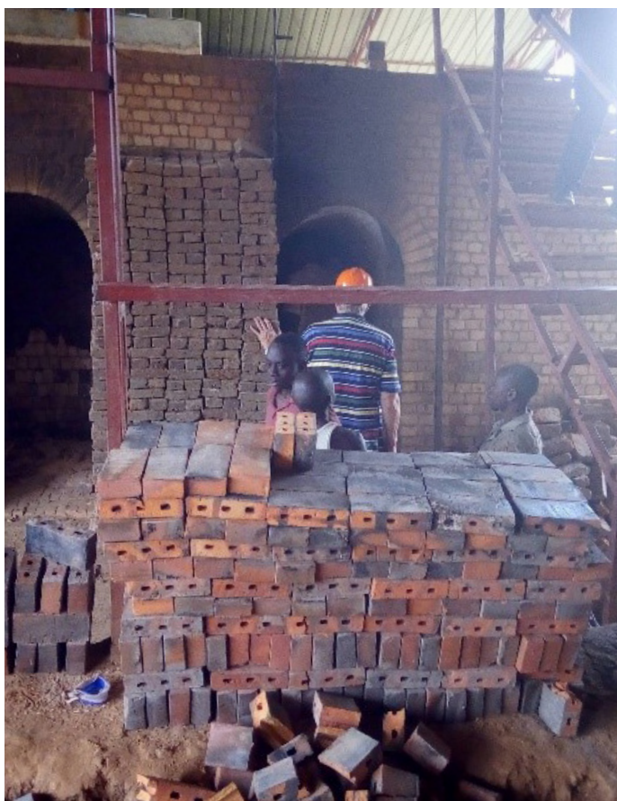
Briques surcuites empilées à l'extérieur du four
