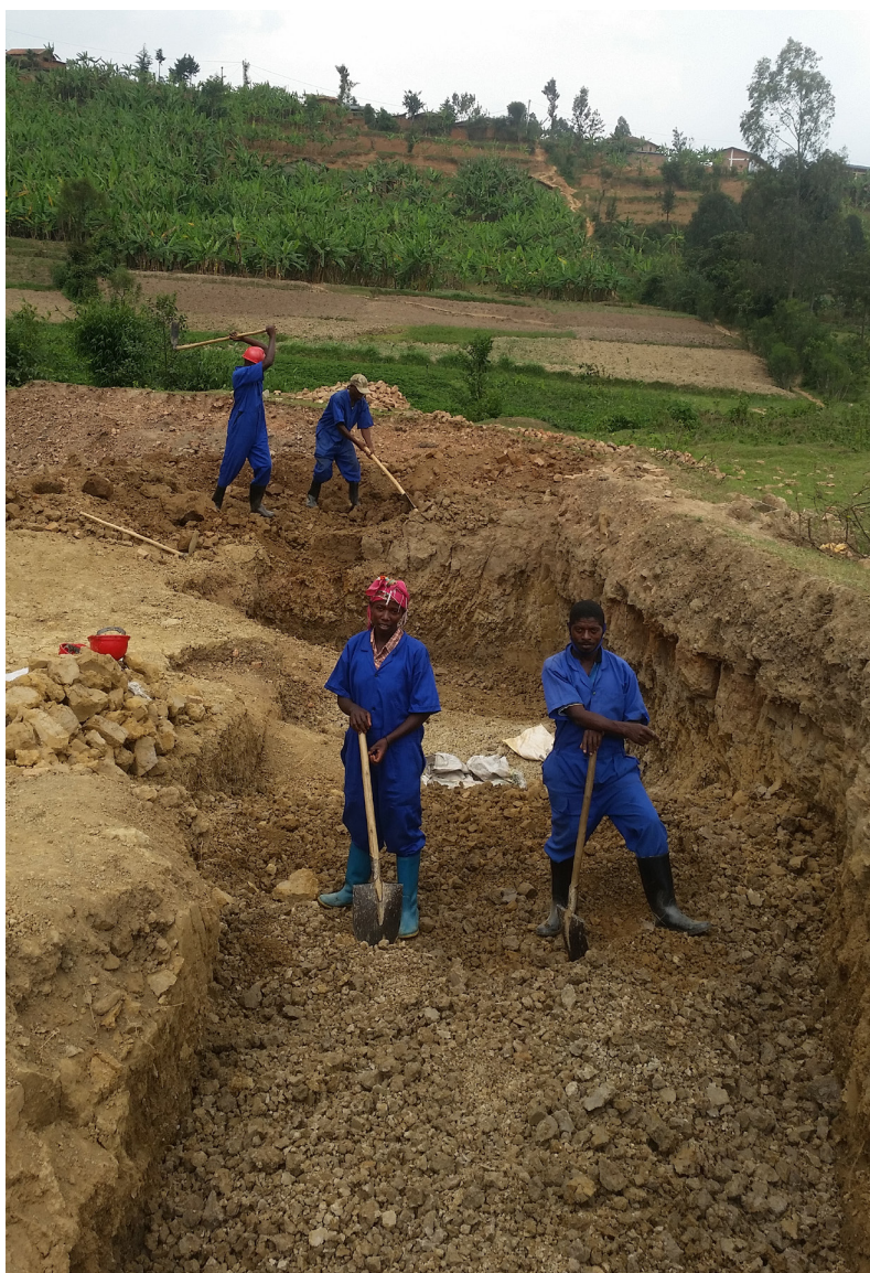
excavation d'argile à la carrière.
