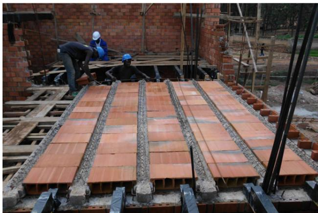
Placement des blocs Maxspan à l'intérieur des poutres préfabriquées
