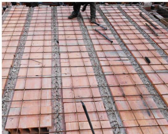
Treillis d'armature de la chape supérieure ancré aux poutres préfabriquées.
