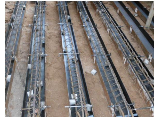
Coffrages Maxspan prêts pour le coulage du béton.
