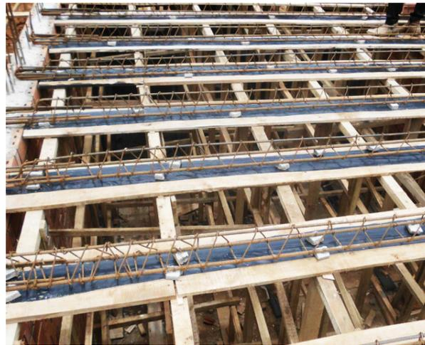
Armature in-situ positionnée sur les coffrages en bois.
