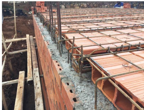
Vue détaillée de la connexion entre les armatures en acier et le tirant en dessous.
