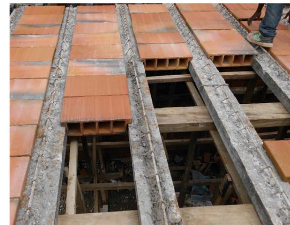
Blocs Maxspan placés à l'intérieur des poutres préfabriquées
