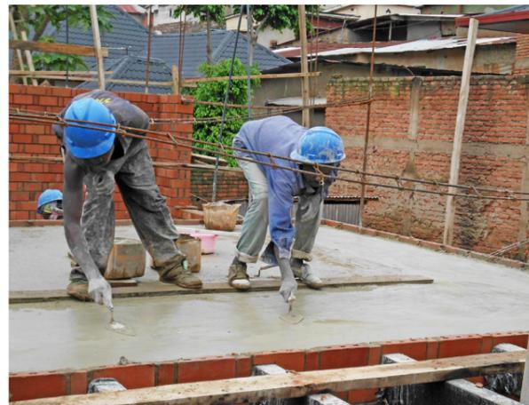
Travaux de finition après le coulage de la dernière couche de béton de ciment.
