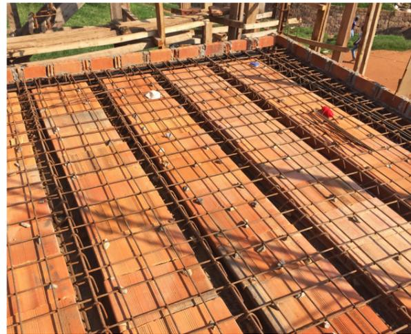
Blocs Maxspan positionnés entre les renforts.
