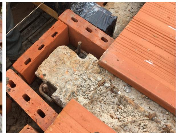
Blocs Maxspan placés à l'intérieur des poutres préfabriquées
