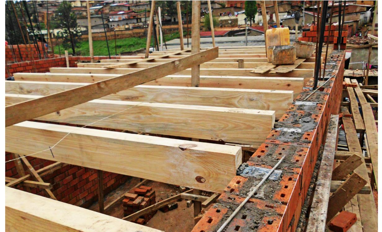
Exemple de l'installation d'un plancher en poutres de bois sur un système de maçonnerie RLB.
