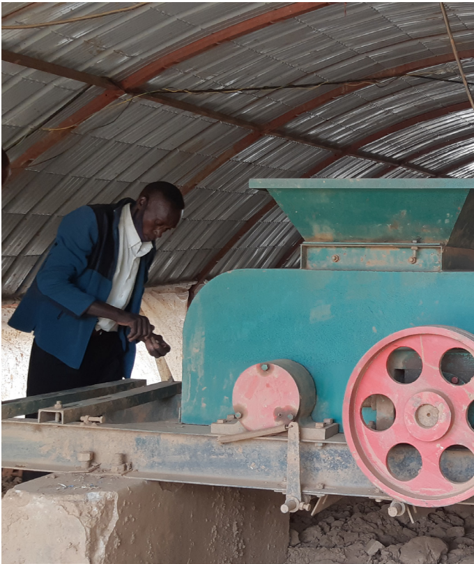
Inspection de l'état de machine
