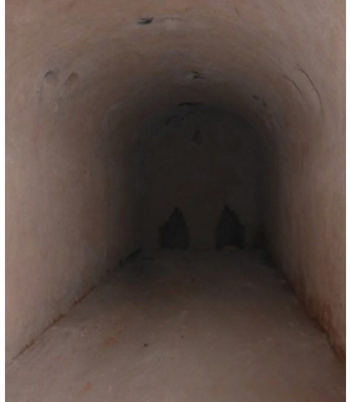
Le four après sa maintenance
